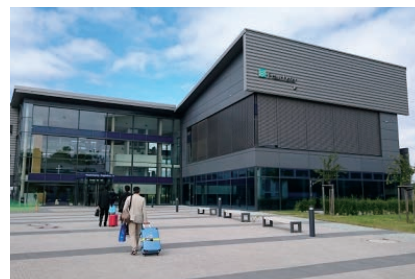
フラウンホーファー研究所外観
