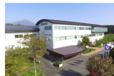
2004(平成16)年 機械素材研究所 (米子市日下)
